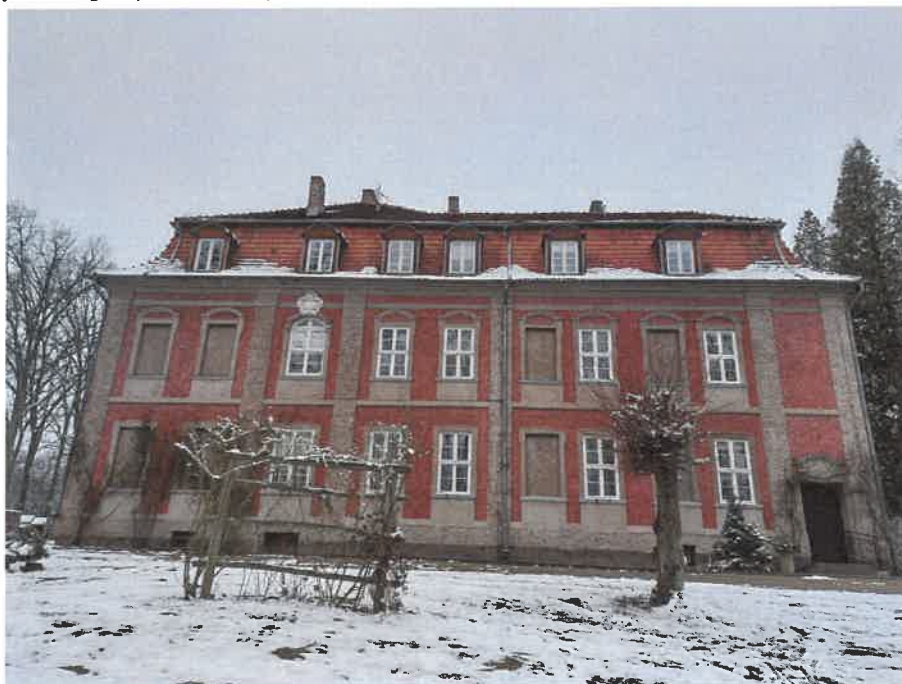
fot. 1. ogólny widok budynku
