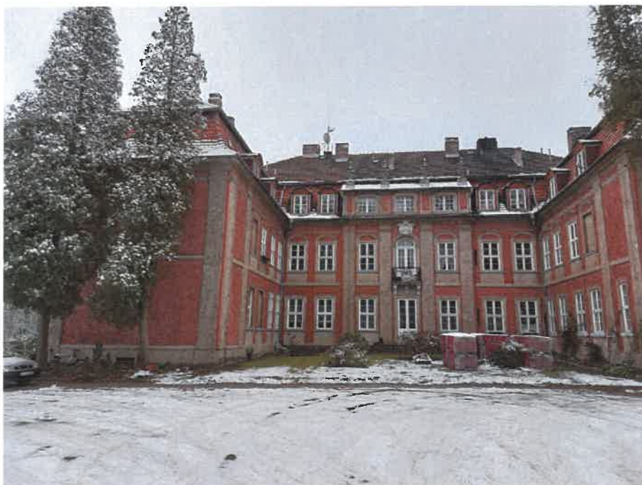
fot. 2. widok budynku od strony dziedzińca
