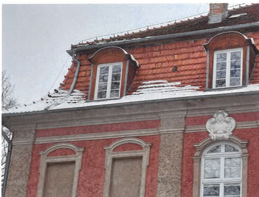
fot. 4. widok lukarn i kształt mansardu
