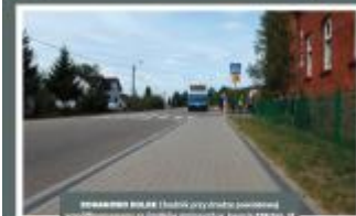
WOLSKO Budowa chodnika przy drodze powiatowej wyłączonej do drożnicy gminnej w Wolku. 150 tys. zł
